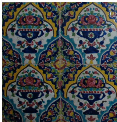
شکل ۱۹ کاشی‌کاری هفت‌رنگ ازاره‌های شبستان جنوبی مسجد - مدرسه سپهسالار قدیم
