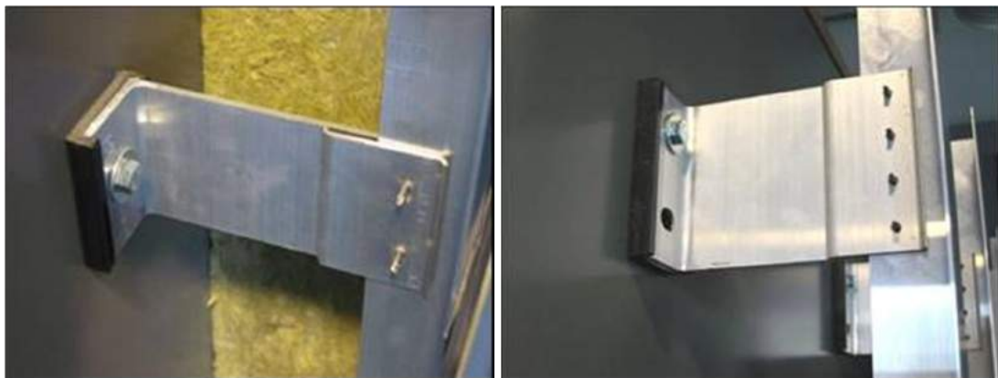
شکل ۶-۴- اجرای زیرسازی با استفاده از قطعات آلومینیومی با قابلیت تنظیم بر روی دیوارهای خارجی
