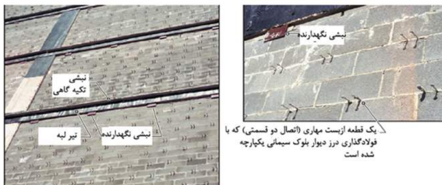
الف - نشی های نگهدارنده به زیر تیر لبه اتصال می یابد. فواصل این نشی ها تابع بار جانبی اعمال شده به دیوار است.
