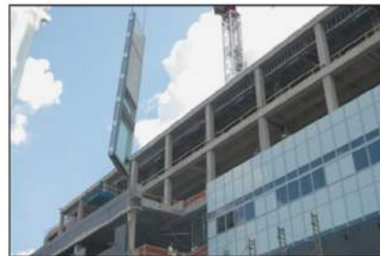
با استفاده از جرثقیل قطعات دیوار برده ای به محل نصب حمل می شوند
