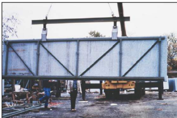
شکل ۴-۲۵- پانل دیواری پرده‌ای پیش‌ساخته سنگی
