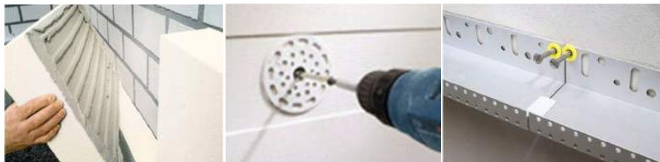
شکل ۱-۲- نمونه‌ای از نمای اتیکس و شیوه مهار آن
