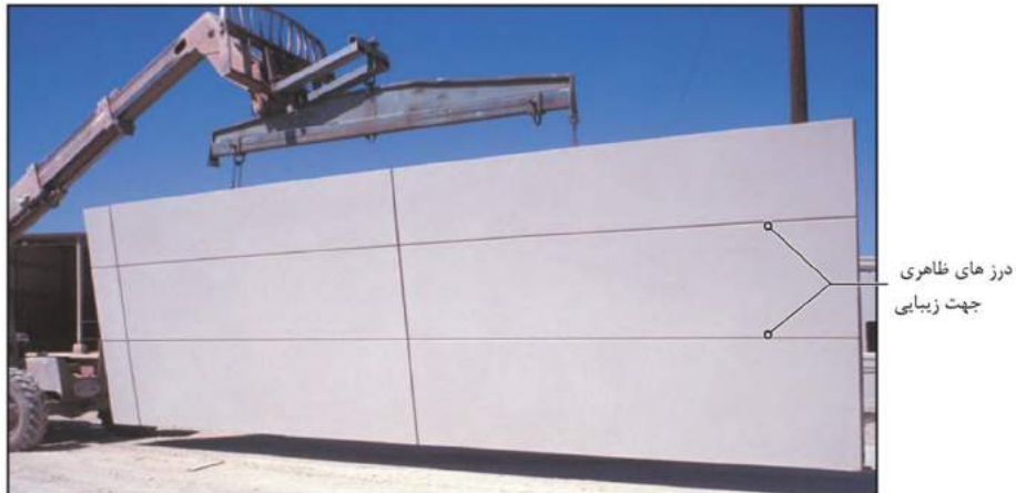
شکل ۶-۳۷ الف - سطح بیرونی یک پانل GFRC، در حال حمل در کارگاه
