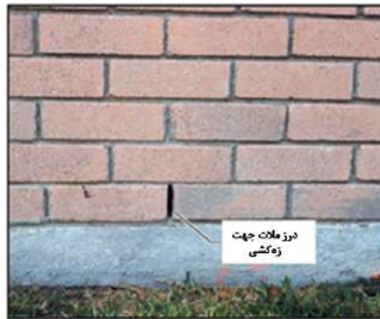
شکل ۵-۱۵- خالی گذاشتن درز ملات جهت زه‌کشی
