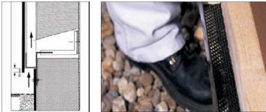
شکل ۶-۶۱- اجرای شبکه توری زیر دیوار
