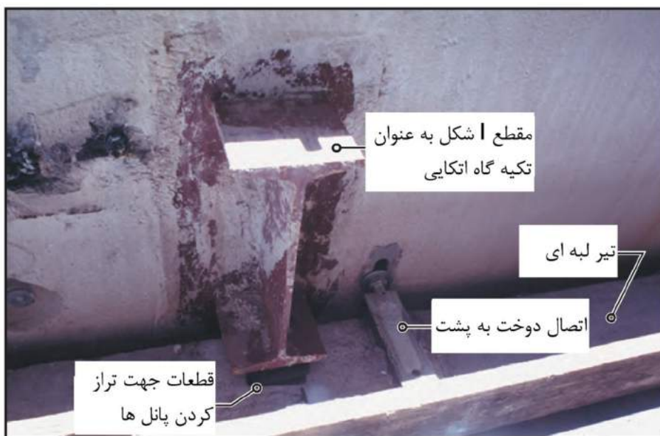
شکل ۶-۲۹- استفاده از پروفیل I شکل به عنوان تکیه‌گاه اتکایی در پانل‌های بتنی پیش ساخته
