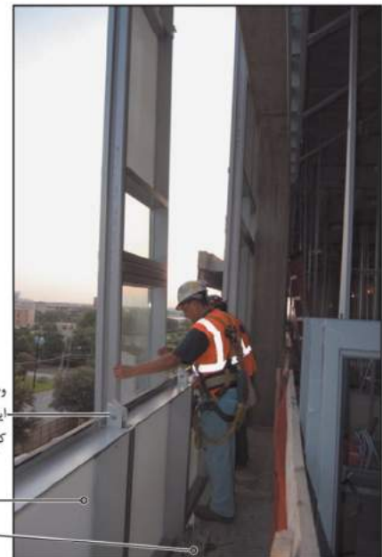
وصله ها در قطعه زیرین. این وصله ها جهت توسعه نما و نیز جابجا کردن آنها کاربرد دارند. قطعاتی که نصب شده اند بست های بار ثقلی
