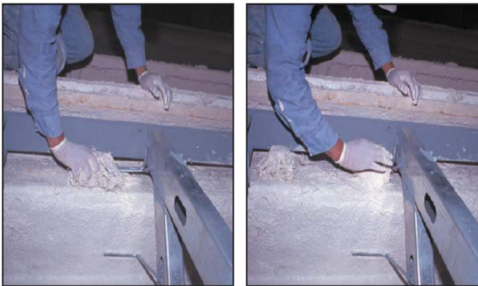
شکل ۶-۴۳- ساختن لایه‌های پیوندی
