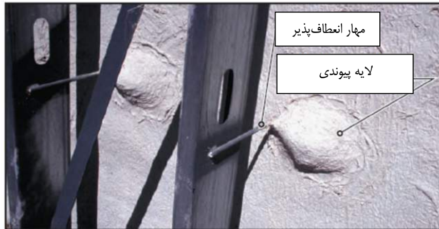
شکل ۶-۳۸ - لایه پیوندی و مهارهای انعطاف‌پذیر
