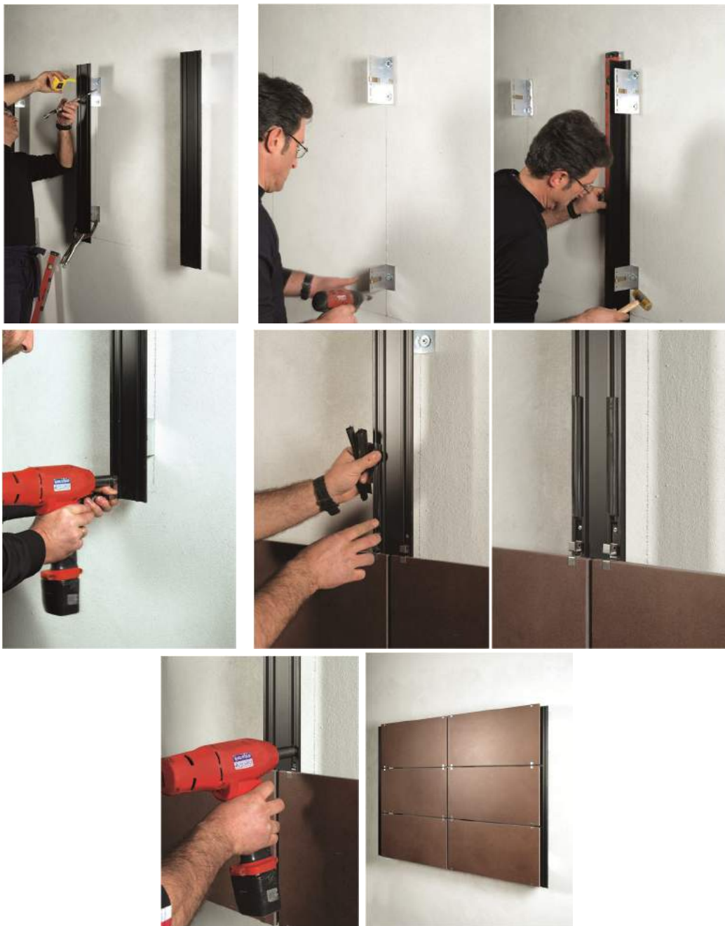
شکل ۷-۲۴- مراحل نصب سیستم نصب نمایان
