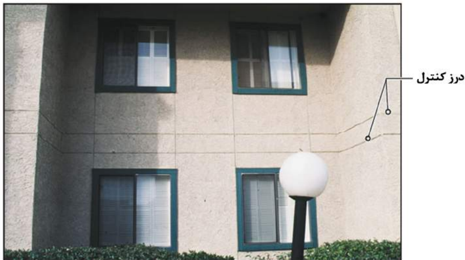
شکل ۶-۸- نمونه درزهای کنترل بر روی نمای سیمانی
